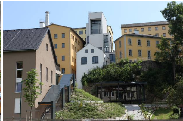
Die ehem. Textilfabrik in Haslach, © R. Gruber
